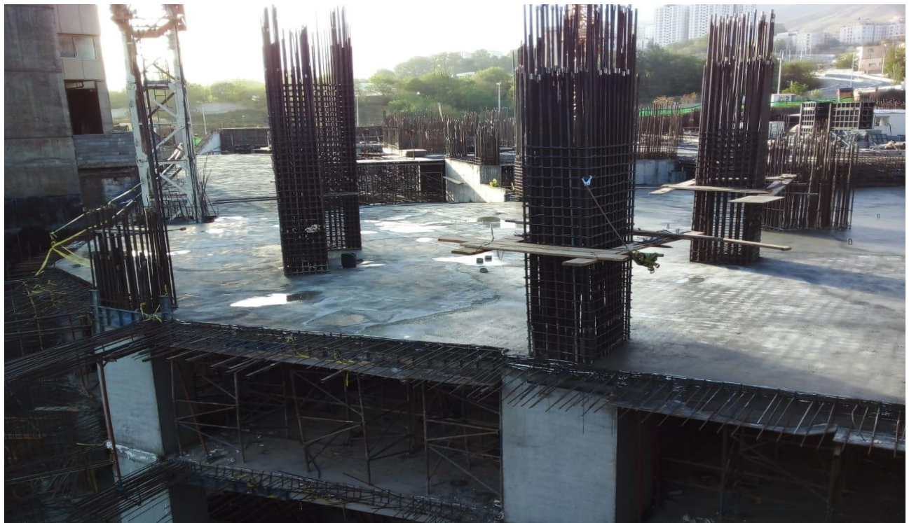
عملیات اجرای اسکلت سازه بتنی و سقف های زیرزمینی پارت جنوبی - فروردین 1401
