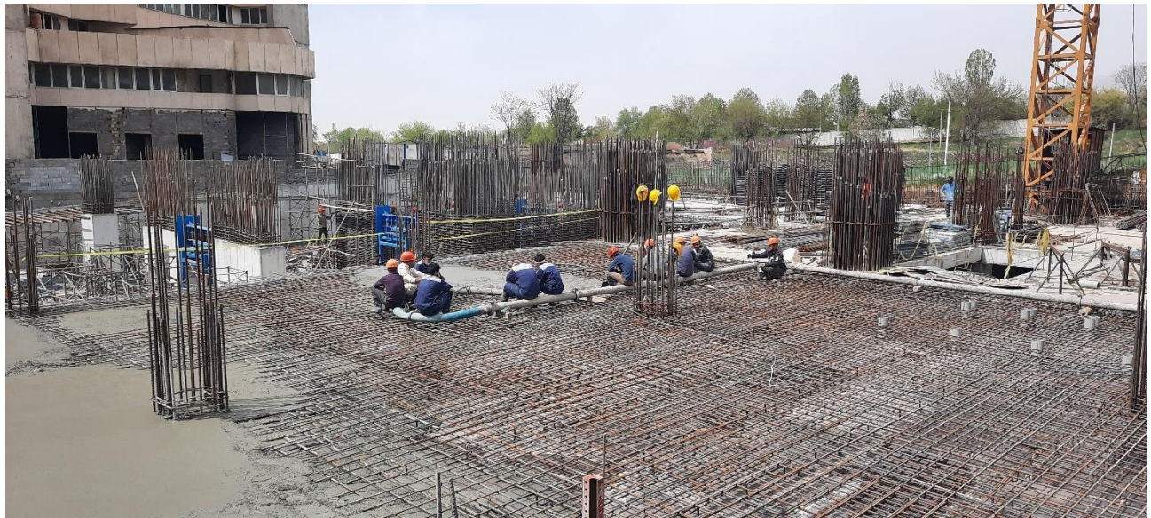
عملیات اجرای اسکلت سازه بتنی و سقف های زیرزمینی پارت جنوبی - فروردین 1401
